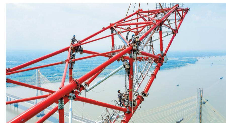
8月16日，位于安徽省铜陵市枞阳县的长江跨越塔北塔封顶，标志着“西电东送”重点工程白鹤滩至浙江±800千伏特高压直流输电工程安徽段长江跨越塔全部组立完成。白浙线是我国实施“西电东送”战略的重点工程，送端连接目前世界在建最大水电站白鹤滩水电站，受端位于杭州临平区浙北换流站，线路全长2140.2公里。图为安徽送变电工程有限公司施工人员在封顶施工现场作业。
