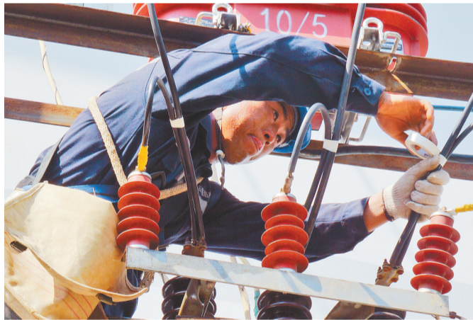
在昭通永善县10千伏明通线冒水孔支线9号杆抢修现场，南方电网云南昭通永善供电局检修人员正在变压器上端聚精会神地更换互感器。 丁福银 摄
