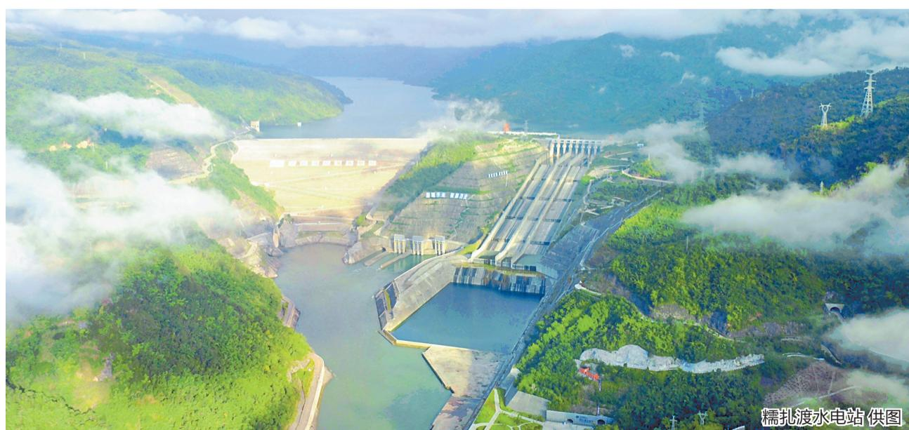
“为了保障下游河道鱼类产卵的水温需求,糯扎渡水电站进水口采用叠梁门分层取水方案,提高下泄水温。”近日,记者来到普洱市糯扎渡水电站,现场工作人员介绍了澜沧江生态环境保护的情况。
