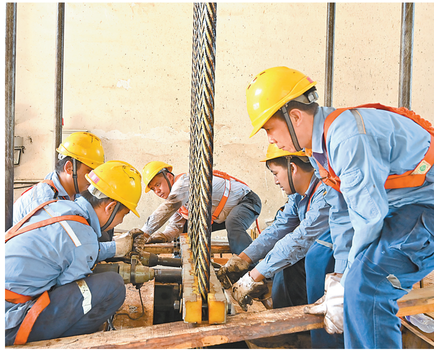
在东部箕斗竖井首绳更换中对新钢绳安装复合卡
