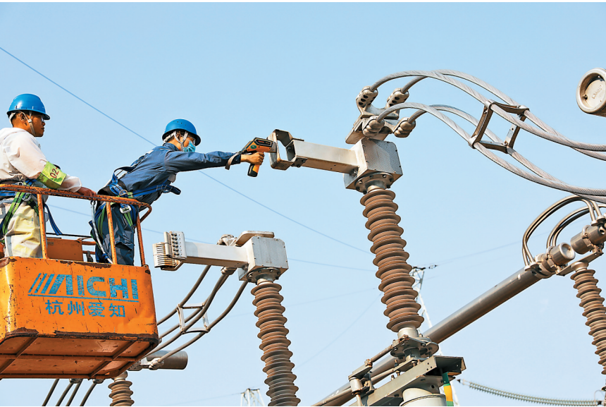
工作人员进行500千伏永仁换流站隔离开关镀银层检测
