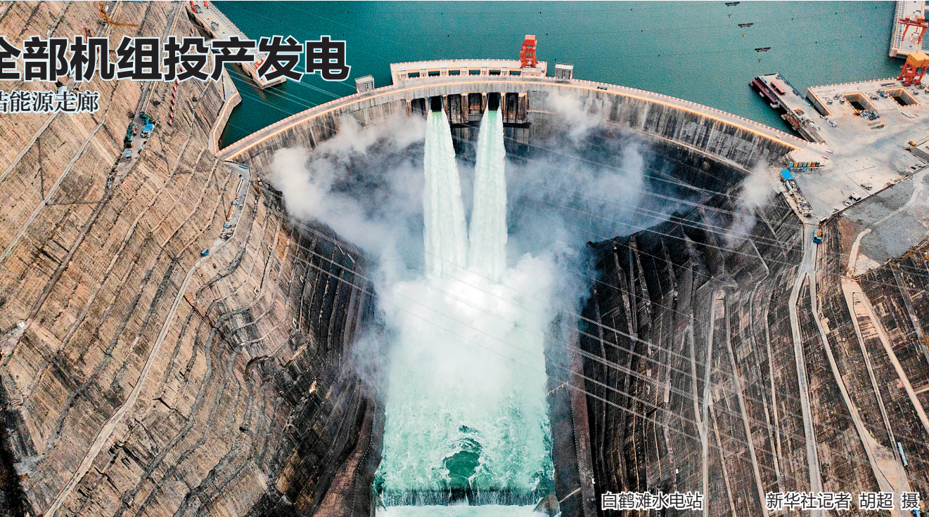
白鹤滩水电站
