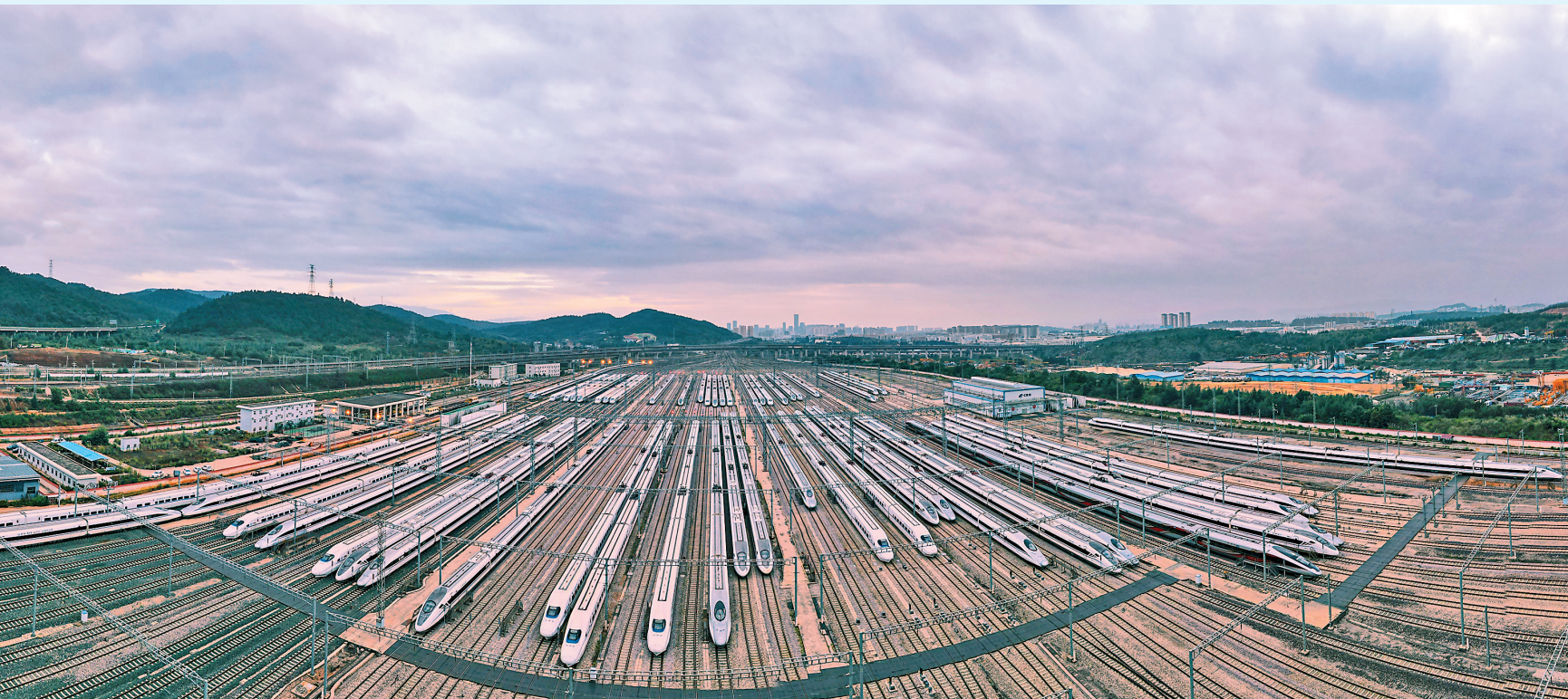
昆明动车所主要承担沪(上海)昆(昆明)高铁、云(云南)桂(广西)铁路、昆(昆明)广(广通)大(大理)、大(大理)临(临沧)铁路、昆(昆明)玉(玉溪)等城际动车的运用、检修与整备功能。经过几年的扩能改造,目前该动车所共有10条检修线、58条存车线,成为中国西南地区最大的动车所。
