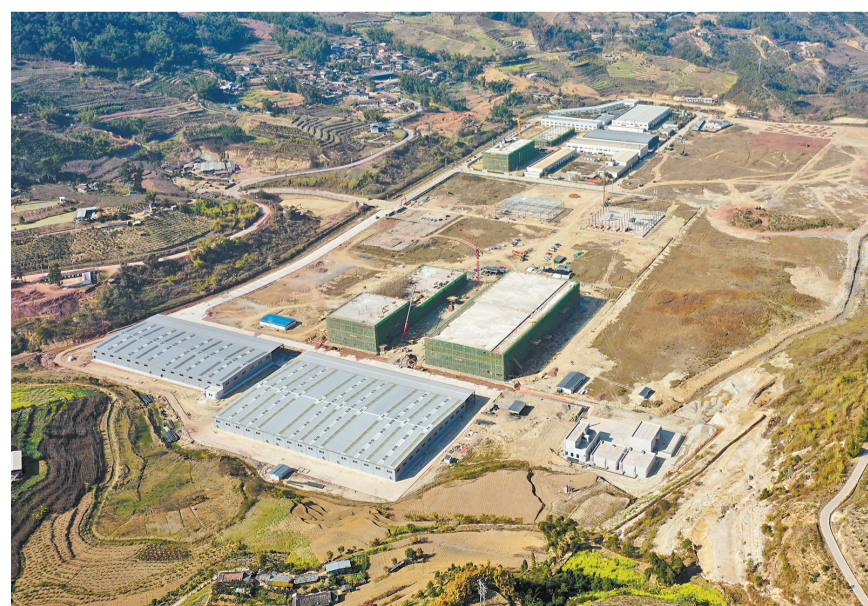
镇沅冷链物流园区建设提速
