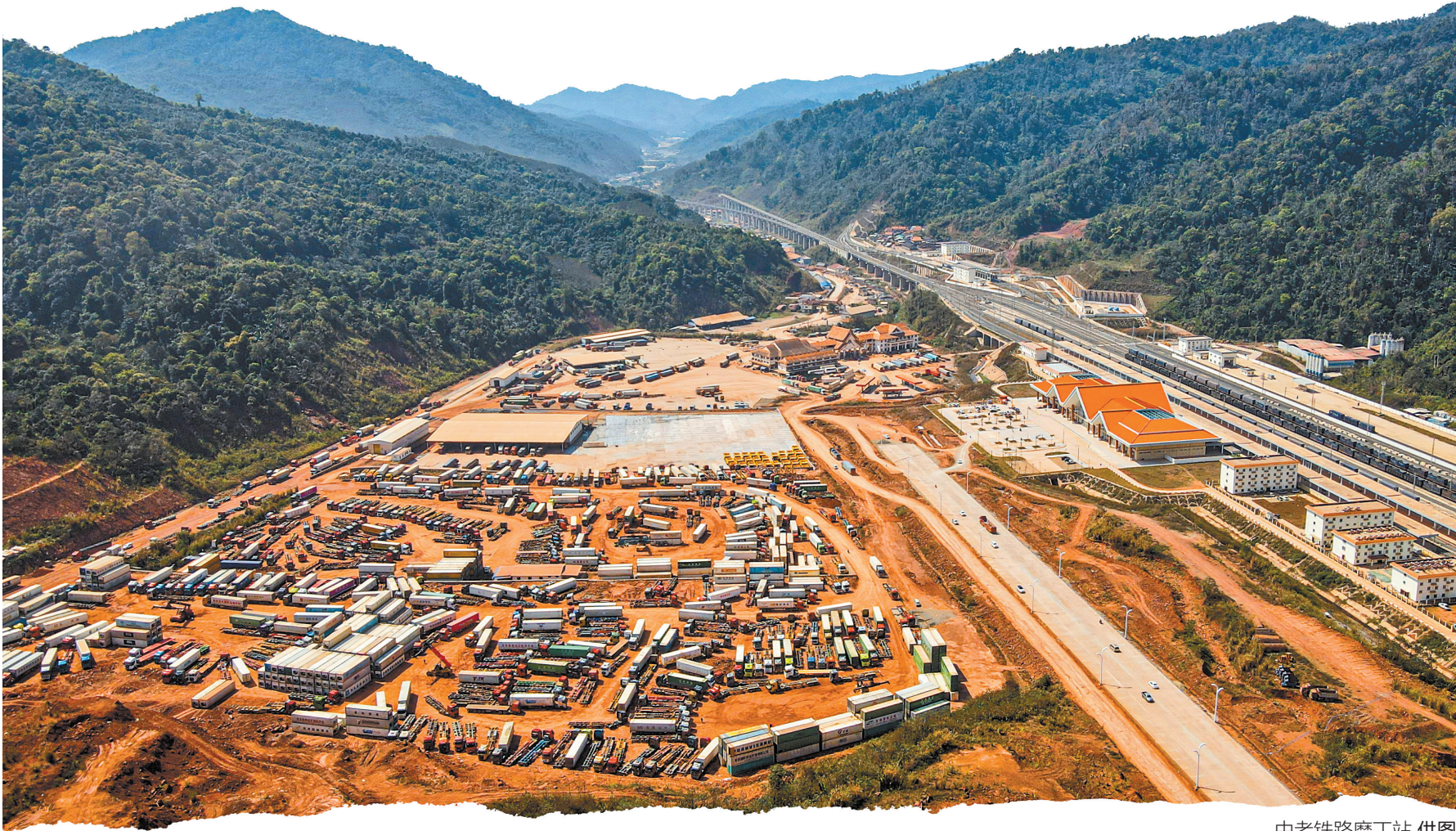
中老铁路磨丁站 供图
