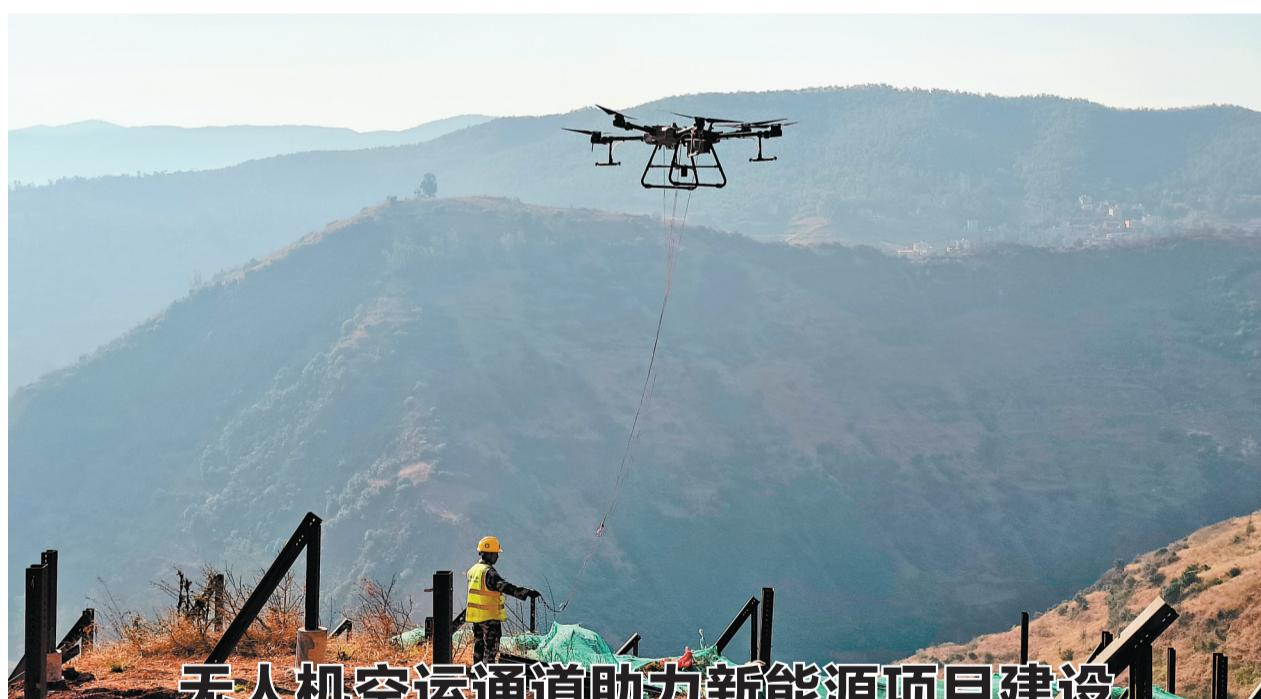
今年以来,华电集团云南区域开辟出光伏组件无人机空中运输通道,加速光伏等新能源建设。华电云南区域近年开工建设了 42 个风光电新能源项目,项目多位于地形地势复杂的陡坡山地,无人机吊运光伏组件一天的完成量相当于 12 名人工的工作量,大幅节约了时间和人力成本。
