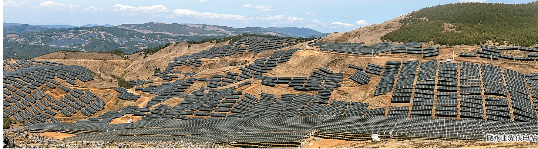
从高原深谷边地，到连片光伏铺陈，位于禄劝彝族苗族自治县的撒永山呈现新景象。5235亩土地分为5个地块进行光伏板布局，50多块单晶硅光伏板倾角24°，接收日光的照射。1000多台逆变器集中入驻就地升压，新建220千伏升压站有序运作。太阳的能量，在这里被集中转化为可再生能源电力，通过电网输配，点亮千家万户，支撑产业发展。
