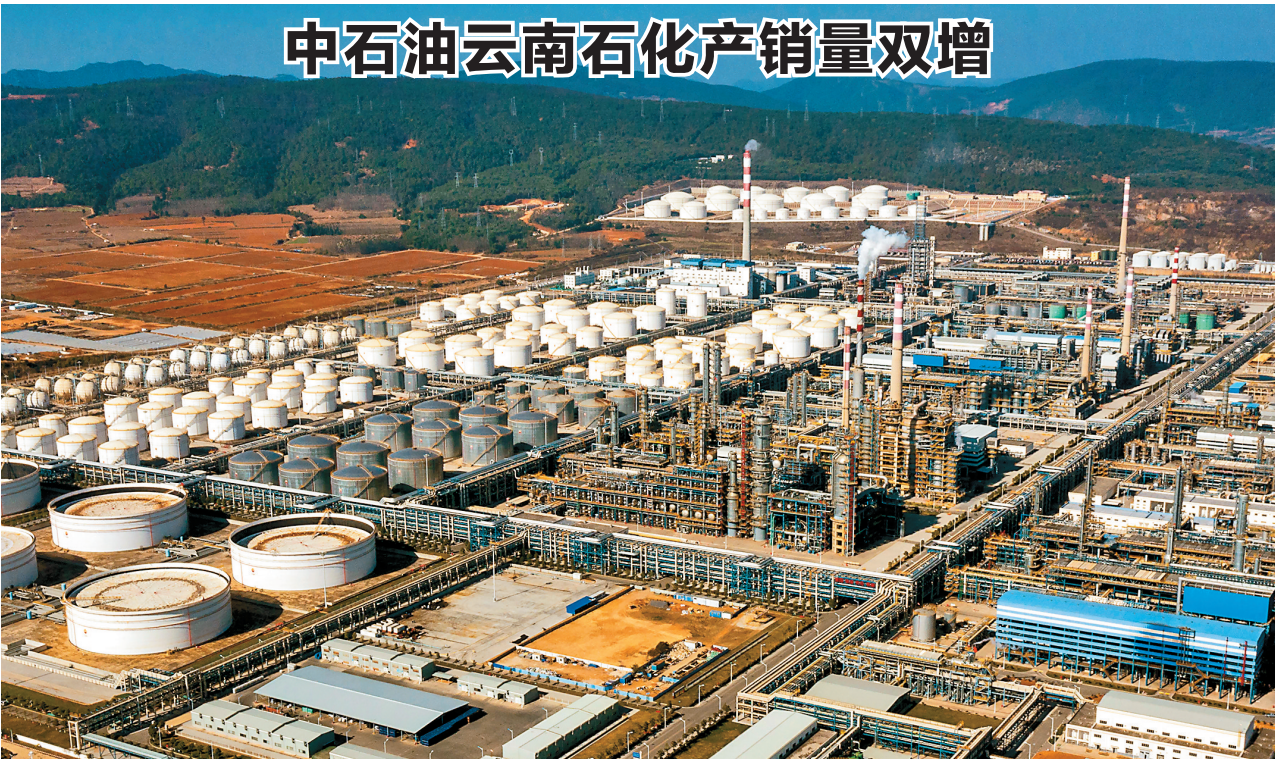
中石油云南石化有限公司强化安全生产与市场保供“两手抓”，今年1至4月实现安全环保稳定运行，累计加工原油344万吨，产品产量和销量实现同比双增，炼油能耗创2017年投产以来最优水平，为云南经济发展提供了稳定能源支撑。图为中石油云南石化有限公司1300万吨/年炼油厂区。
