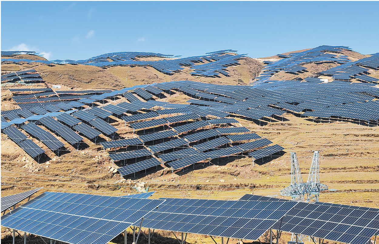
海坝光伏发电项目。
