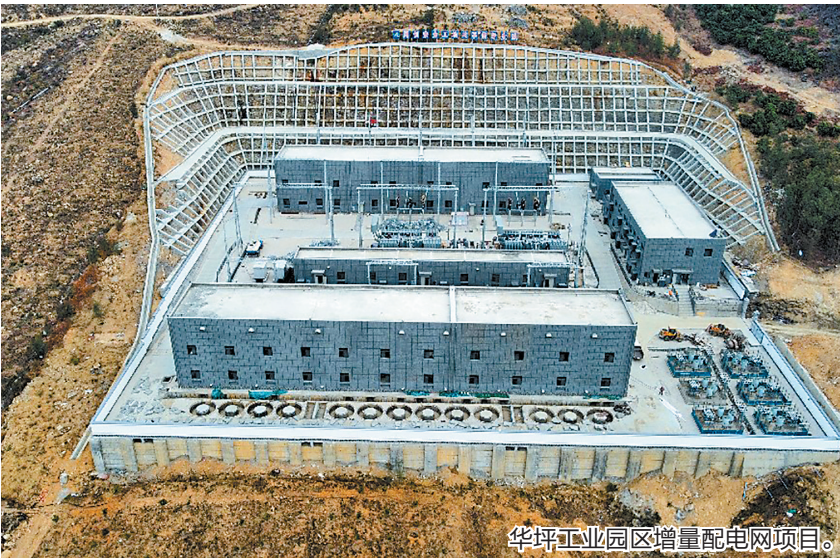
华坪工业园区增量配电网项目。
