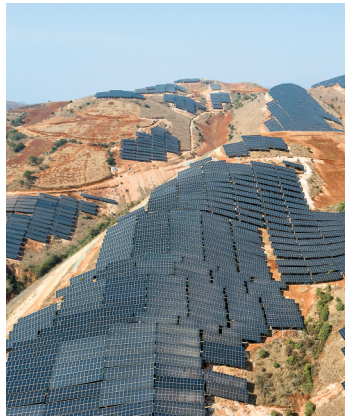
保山杨柳光伏发电项目
