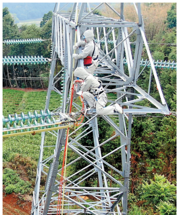
输变电工程带电作业
