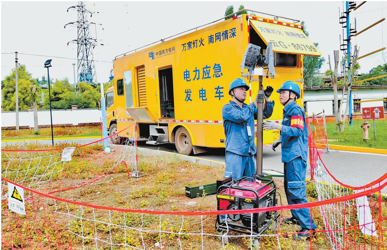
红河供电局应急特勤队参赛人员搭接应急发电车照明设备
