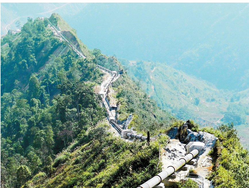
铺设在山脊的小中河水电站压力钢管
