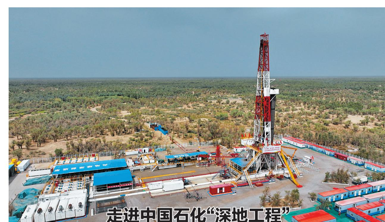
位于新疆塔里木盆地塔克拉玛干沙漠的中国石化“深地工程”——顺北油气田平均埋藏深度超过7300米，是世界陆上最深的商业开发油气田之一。顺北油气田目前已钻成垂直深度超过8000米的井50口，实现了26口“千吨井”（单井日产1000吨的油气井）的重大突破。图为8月21日拍摄的中国石化塔里木盆地“深地工程”跃进3-XOC油气井。该井设计并深9472米，截至8月28日，钻探深度已达8471米（无人机照片）。
