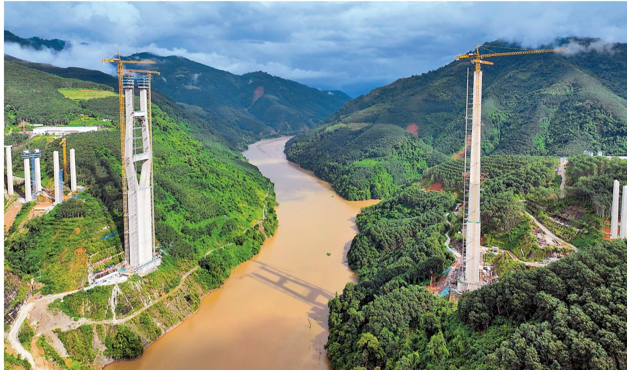
8月27日，勐绿高速公路李仙江特大桥索塔成功封顶，大桥全面进入钢梁悬臂拼装施工阶段。李仙江特大桥全长1112米，为三跨钢混组合梁花瓶形双塔斜拉桥，是勐绿高速公路全线第一控制性工程。此次封顶的索塔高度为250.18米，在我省同类型桥梁中，大桥索塔高度第一、主跨跨度第一。
