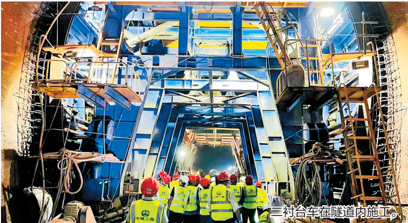
二衬台车在隧洞内施工。
