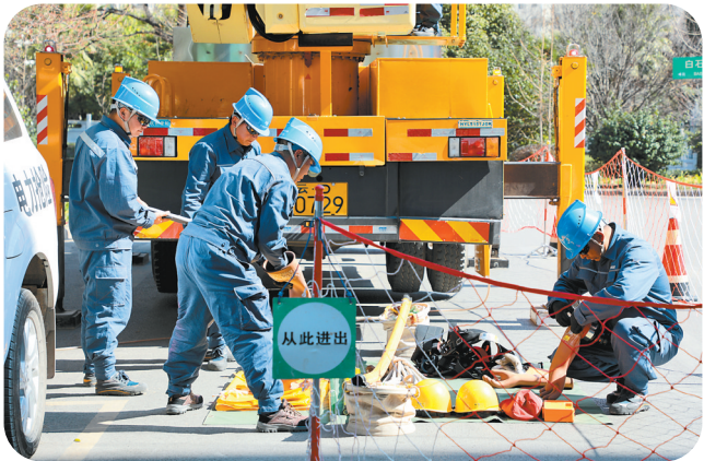
检修作业前检查工器具。阮松萍 摄
