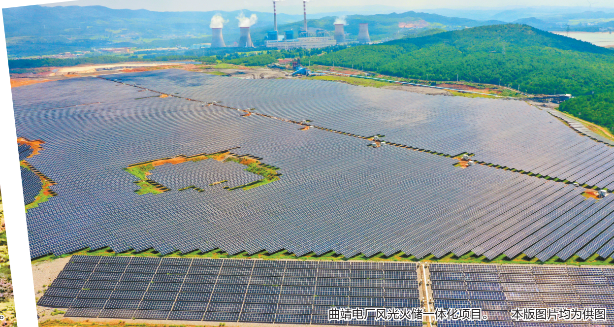
曲靖电厂风光火储一体化项目。 本版图片均为供图
