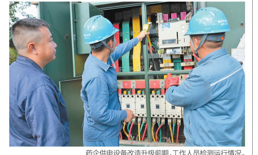
药企供电设备升级改造前期，工作人员检测运行情况。
