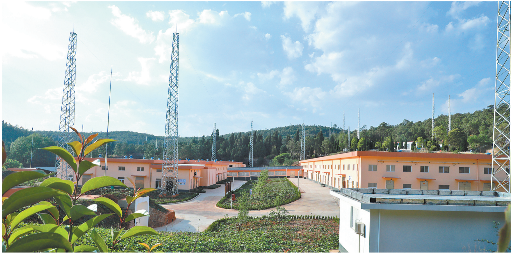
公司成品车间电子雷管工房。
