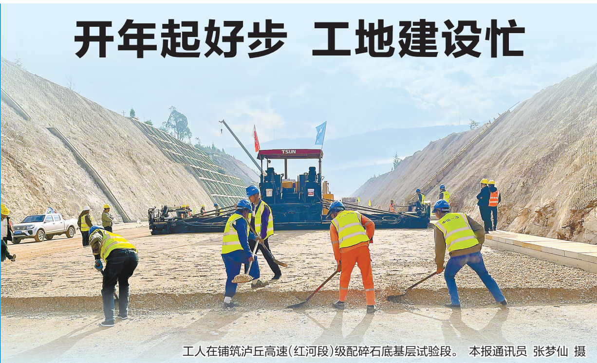
工人在铺筑泸丘高速(红河段)级配碎石底基层试验段。 本报通讯员 张梦仙 摄
