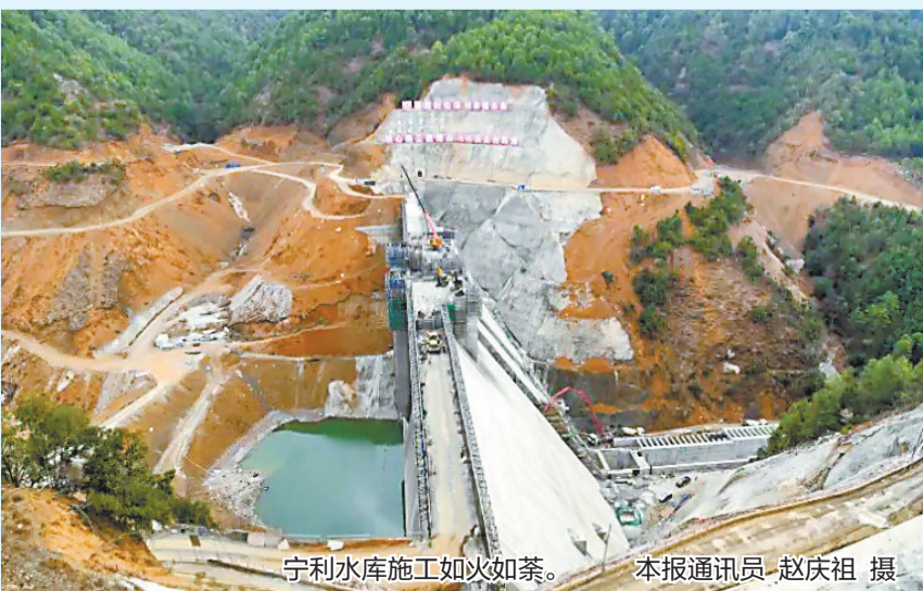
宁利水库施工如火如荼。 本报通讯员 赵庆祖 摄
