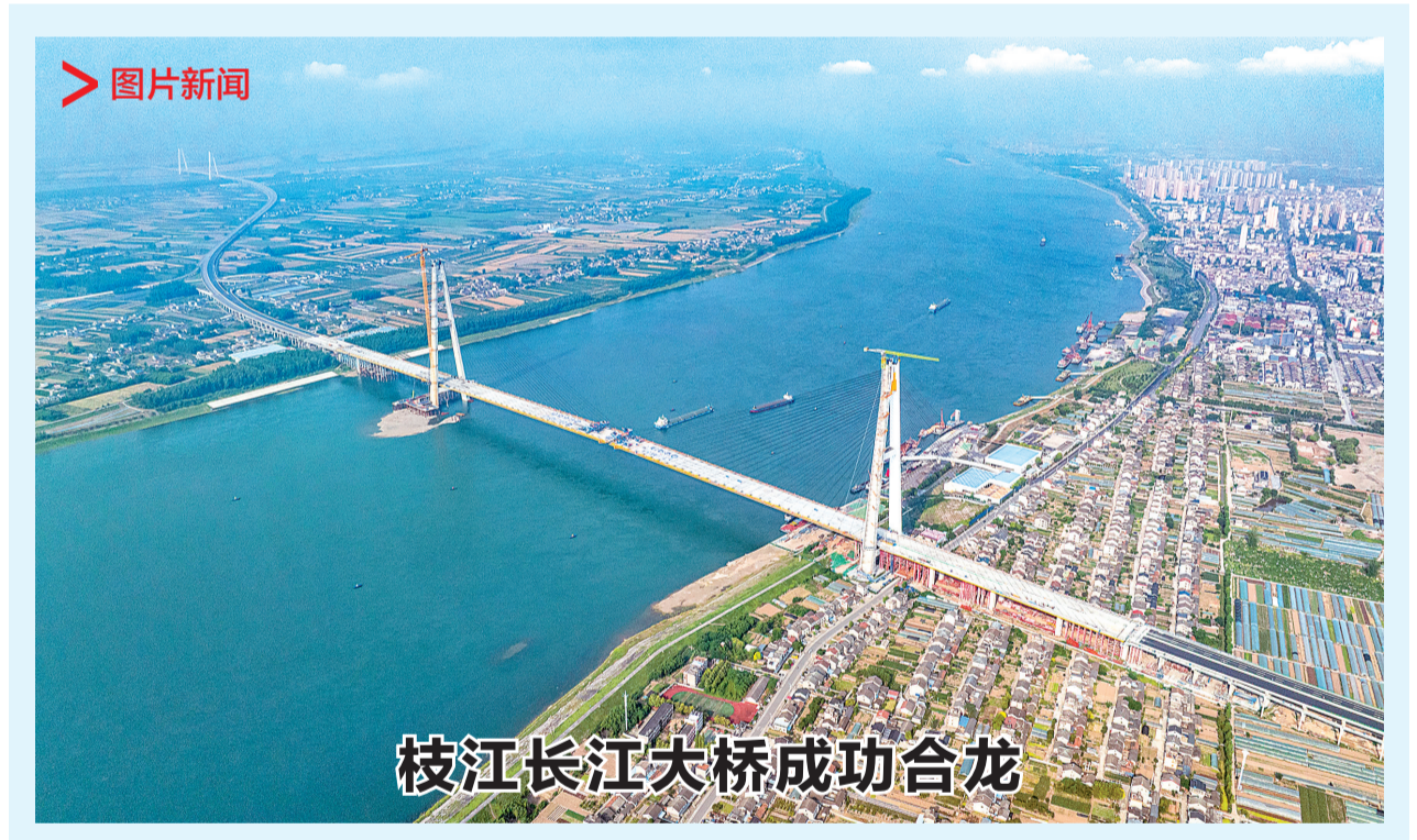
5月15日，由湖北交投集团投资、蜀道集团四川路桥和中交二公局联合承建的枝江长江大桥施工现场迎来关键时刻——随着最后一块钢箱梁精准落位，这座“世界级”斜拉桥在江心完成最后“牵手”，标志着枝江长江大桥顺利合龙。百里洲是长江枝江段一座大型江心洲，面积约228平方公里，人口近10万人。长期以来，洲上的居民出行只能依靠轮渡，大桥建成通车后，百里洲两岸群众过江时间由数小时缩短至5分钟。图为5月15日拍摄的枝江长江大桥施工现场。
